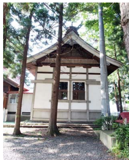
重要文化財「大館八幡神社」 神殿二棟を保護する覆屋
