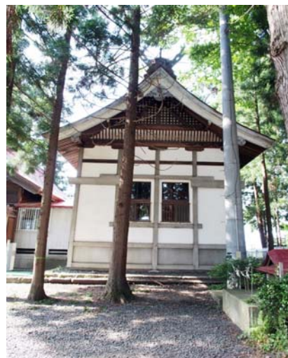
重要文化財「大館八幡神社」 本殿2社を保護する覆屋
