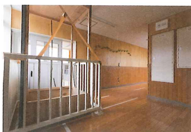
1階で仕込んだ豚肉を2階に運ぶために専用リフトを増設。
