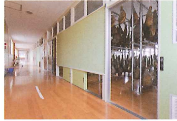
教室の特長である大きな窓と欄間、掃きだし窓で風を取り入れる。
