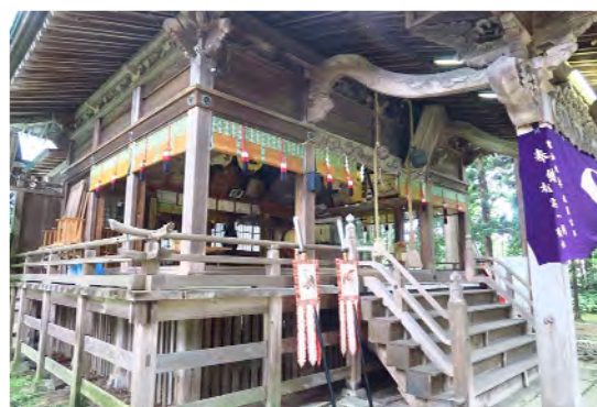
例祭時は拝殿の外部建具が取り払われる
