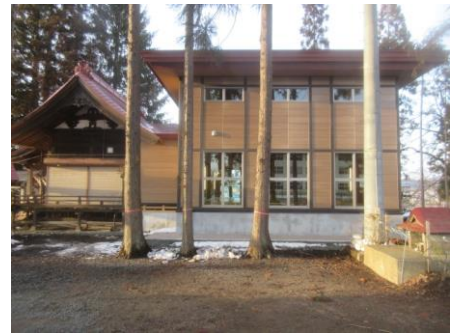
重要文化財「大館八幡神社」 本殿2社を保護する覆屋 (建替後完成写真)
