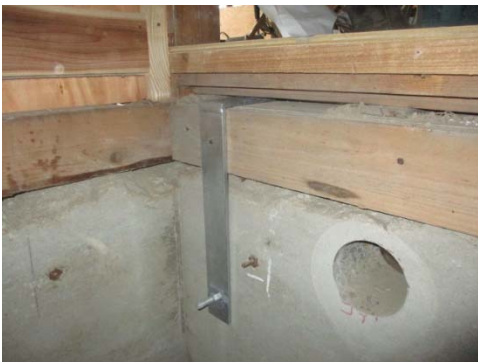
写真 2-4-25 柱脚接合金物 TB1
