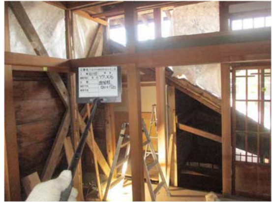
5-8-29 施工中 耐力壁 (④B・C) 土壁・貫全面撤去、筋違残置
