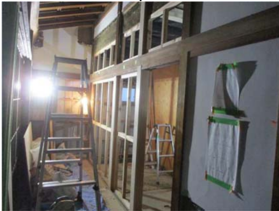
5-8-14 施工中 耐力壁 (②A) 壁全面撤去
