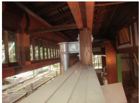
写真 2-4-52 丸鋼管柱 柱頭
