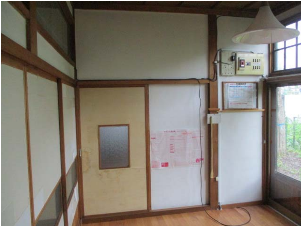
34 施工前 予備室
