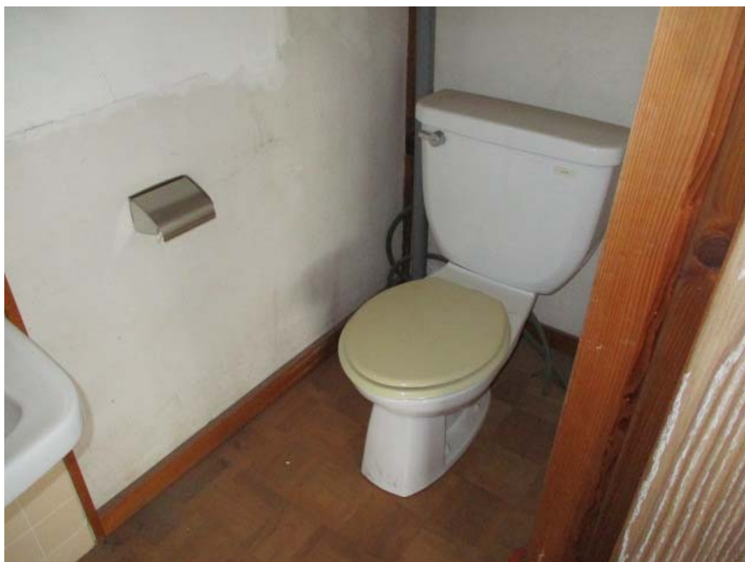
56 施工前 2階便所
