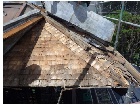
写真 2-4-8 展望台屋根解体
