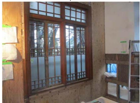
5-8-24 施工中 耐力壁 (③A)
