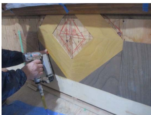
写真 2-4-71 腰壁取付け作業中
