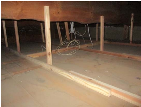
写真 2-4-41 野縁、吊木取付け
