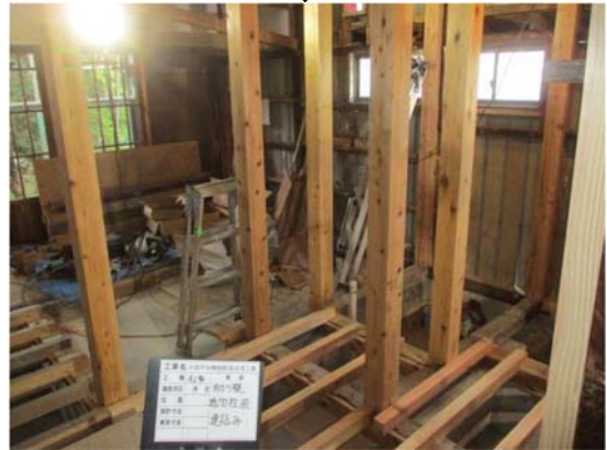
5-8-17 施工中 耐力壁 (②B) 壁下地全面撤去し、柱・梁を追加
