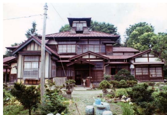
写真 1-1-4 移築前の桜櫓館（東面）
