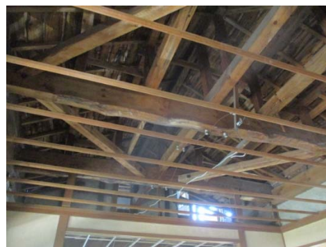
写真 3-1-15 1階和室の火打ち梁
