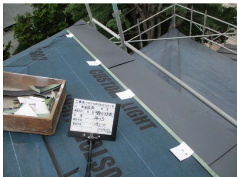
写真 2-4-55 吊り子取付け
