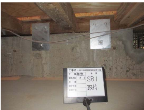
写真 2-4-27 柱脚接合金物 SB1
