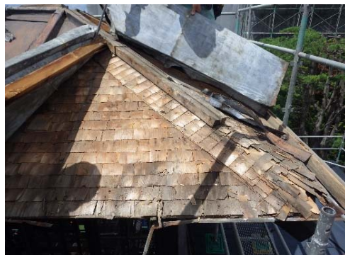
写真3-1-41 展望台金属板下の杉柁葺き材
