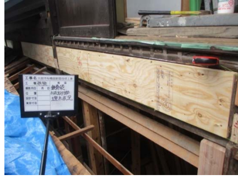
写真 2-4-46 鉄骨梁下地調整材
