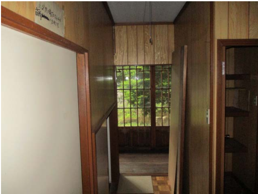
44 施工前 ホール (2) 西面
