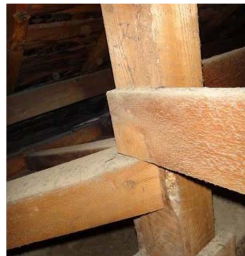
写真 3-1-51 貫板の釘留め
