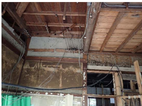
写真 3-1-73 天井裏の配線状況
