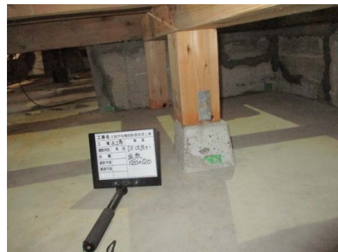
写真 2-4-20 コンクリート製束石新設
