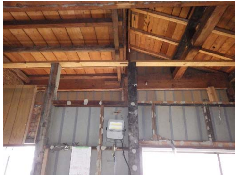
写真 3-1-31 1階台所北側外壁面
