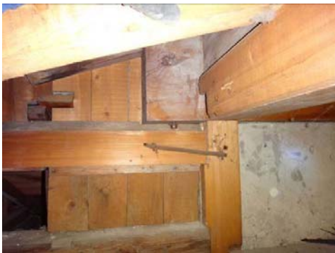
写真 3-1-50 大入れ・鉋による柱-横架材
