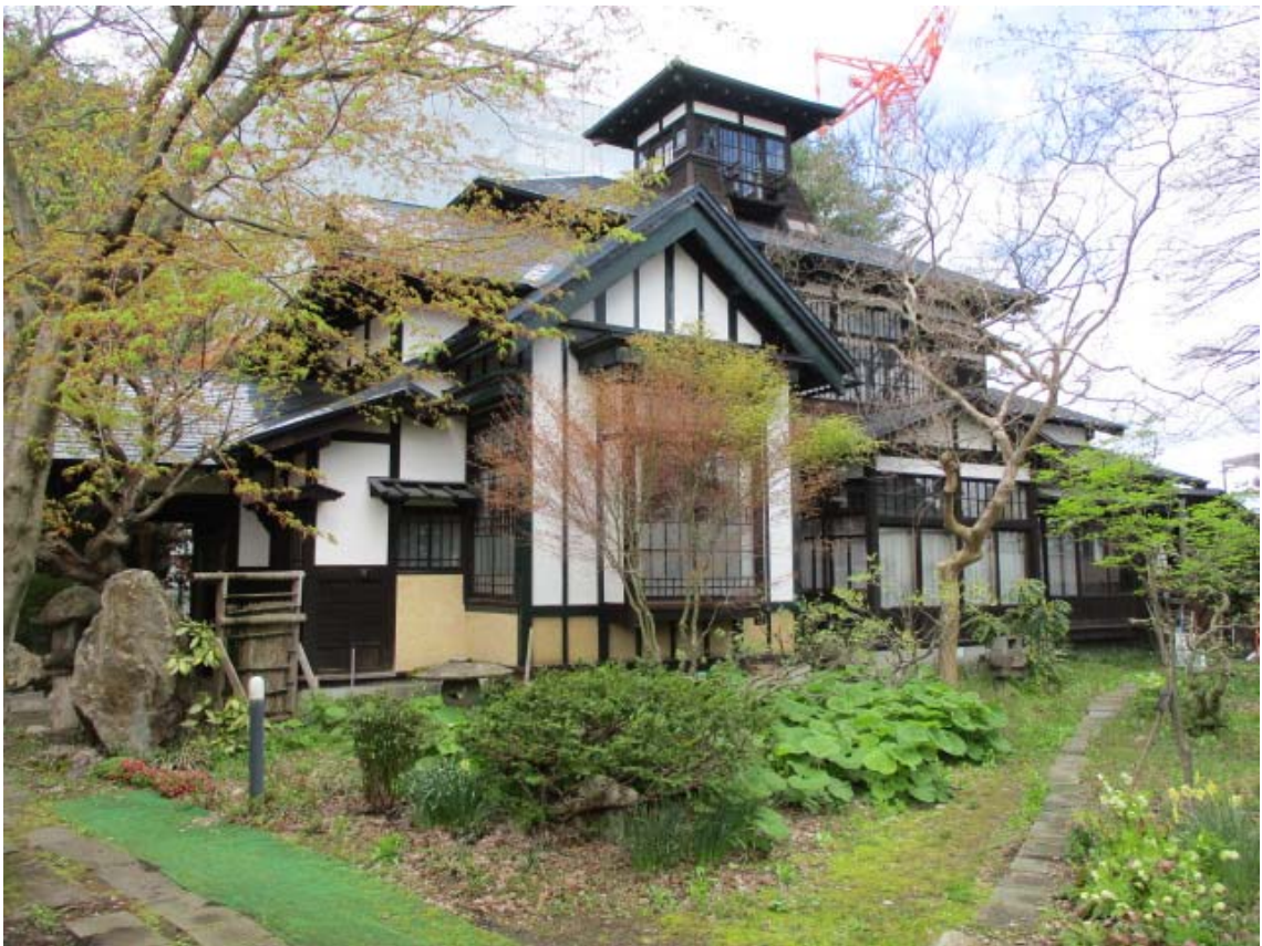
施工前 東・側面全景
