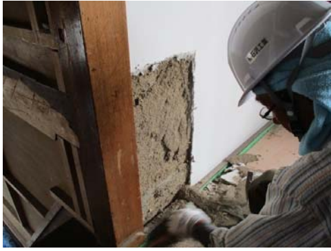
写真 2-4-3 土壁部分解体
