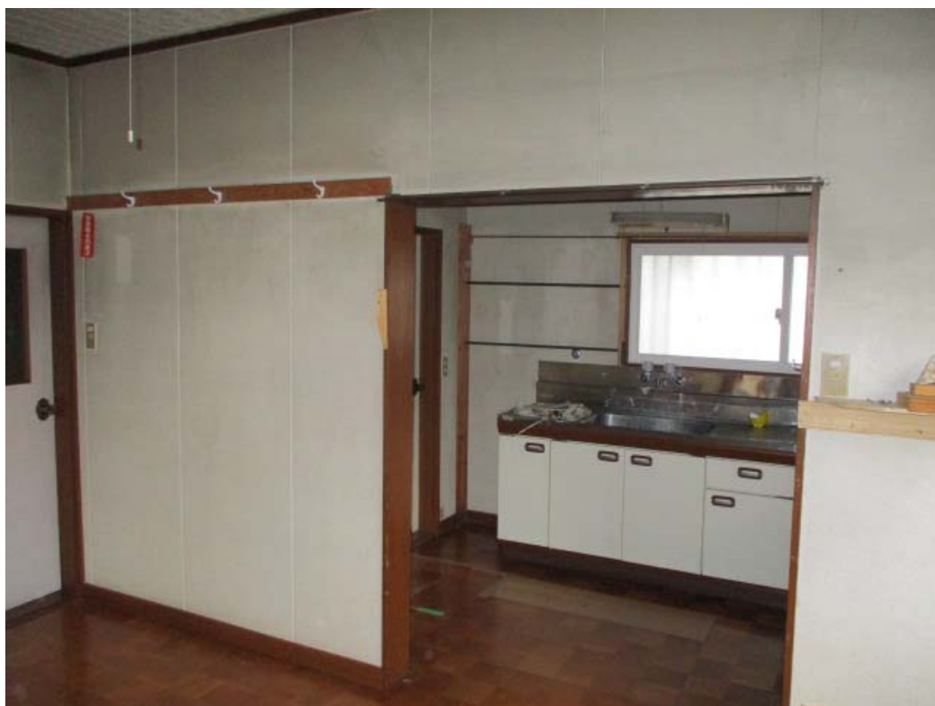
40 施工前 管理人室
