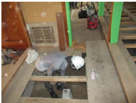
写真 2-4-19 束石施工中
