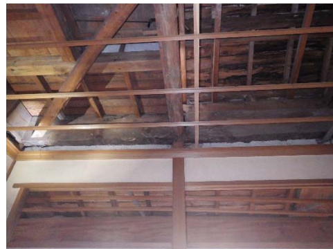
写真 3-1-67 1階和室(2)南側の胴差
