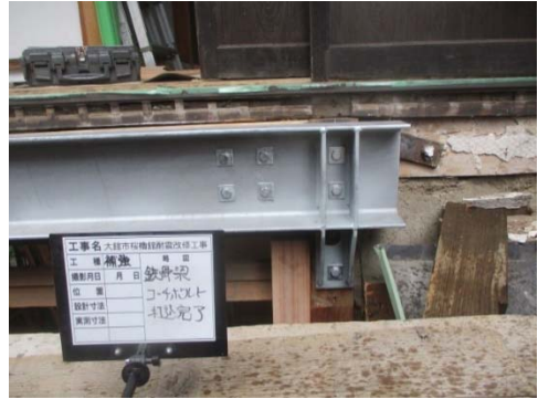
写真 2-4-50 鉄骨梁端部
