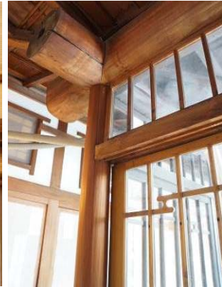
写真 3-1-11 縁側の丸太柱
