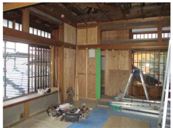
5-8-30 施工中 耐力壁 (④B・C) 構造用合板 (両面・片面) を新設
