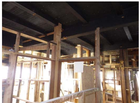
写真 3-1-33 1階浴室等壁下地
