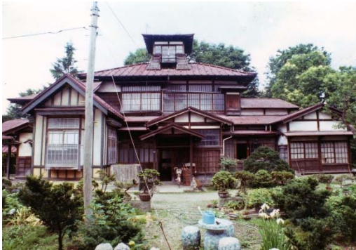
63 古写真 東面外観
