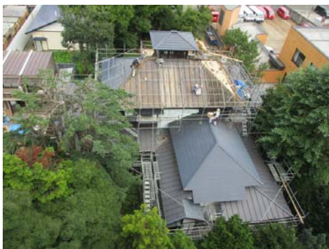
写真 2-4-9 2階屋根解体
