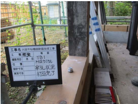
写真 2-4-23 アンカーボルト TB1
