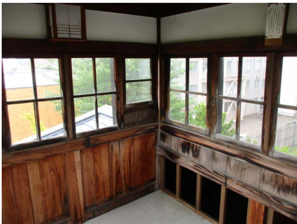
58 施工前 展望台
