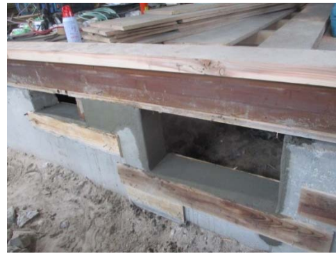
写真 2-4-22 モルタル補修
