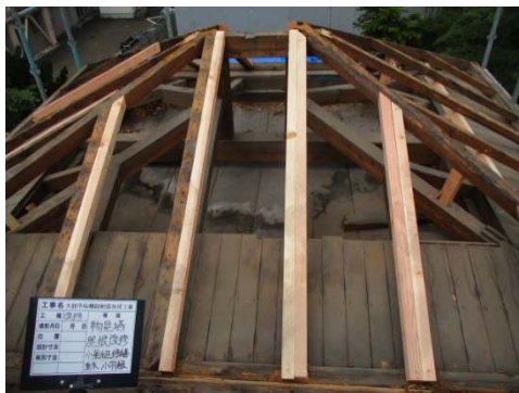
写真 2-4-43 塔屋垂木補強及び取替え
