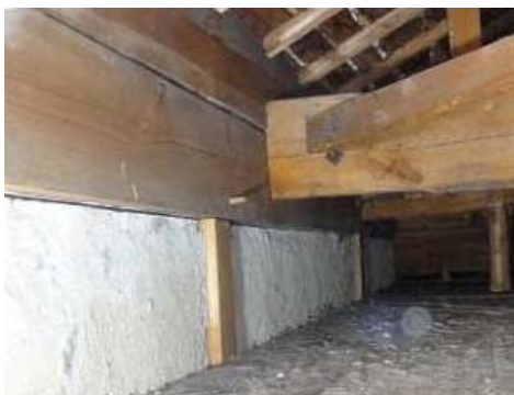
写真 3-1-44 柱-桁(1階和室)
