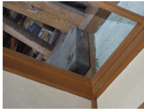
写真 3-1-69 胴差と柱の仕口
