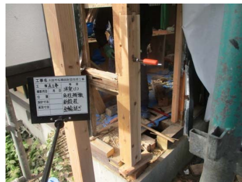
写真 2-4-30 洋室(1)柱 金輪継手
