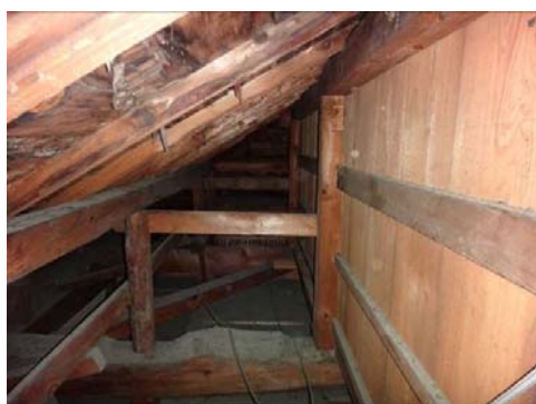
写真 3-1-18 2階小屋組束に対する貫板
