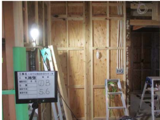
5-8-6 施工中 耐力壁 (①B) 構造用合板を新設
