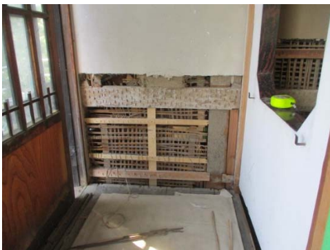
写真 2-4-57 既存の木舞壁
