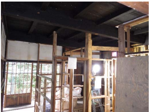
写真 3-1-32 1階ホール(2)壁下地
