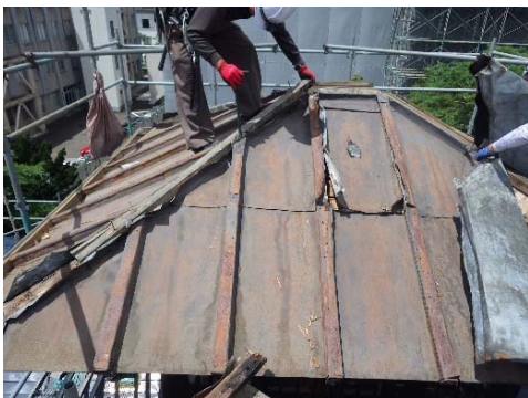
写真3-1-40 展望台表面下地の金属板
