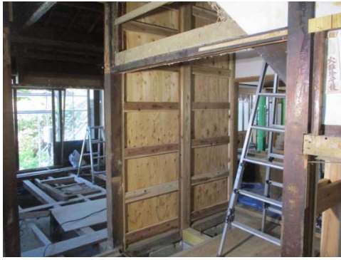
写真 2-4-39 1階構造用合板補強壁
