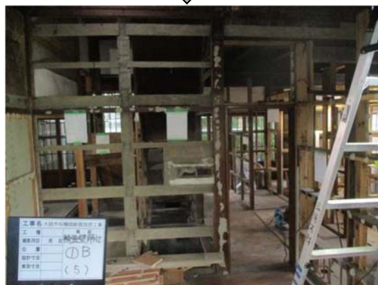
5-8-5 施工中 耐力壁 (①B) 土壁全面撤去、既存貫再使用
