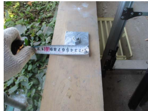
写真 2-4-24 アンカーボルト TB1
