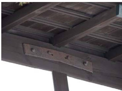
写真 3-1-52 桁継手の帯金物補強
