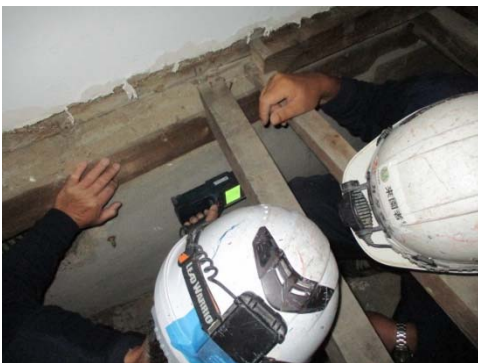
写真 2-4-15 基礎鉄筋探査
