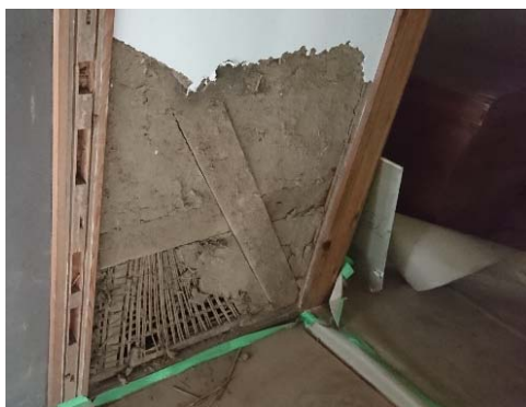
写真 3-1-24 2階縁側(5)の斜材と土壁
