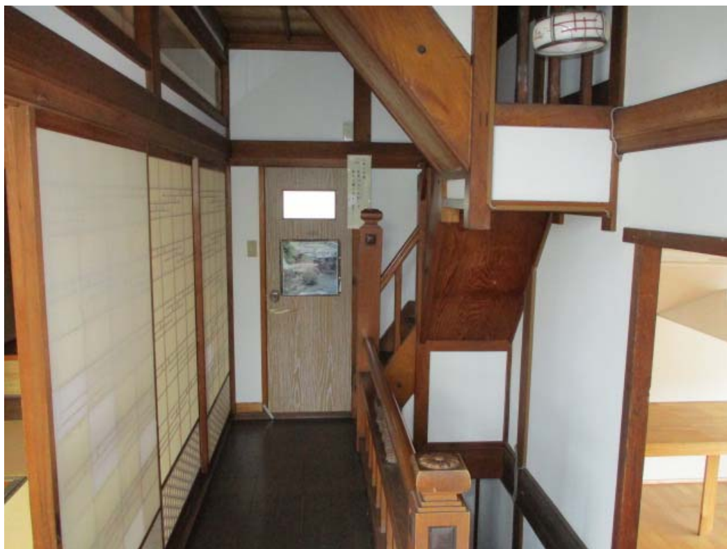
46 施工前 ホール (4) 西面
