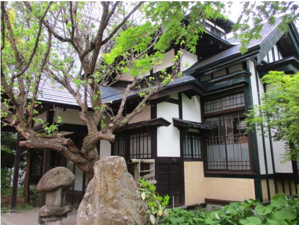
8 南・正面（便所・洋室）
