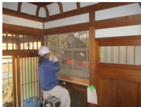
写真 2-4-58 木舞補修作業中
