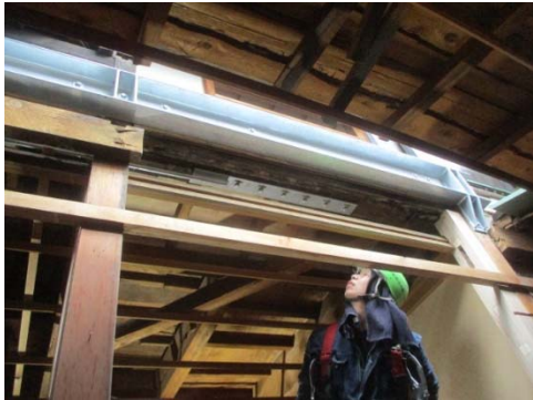
写真 2-4-49 鉄骨梁取付け
