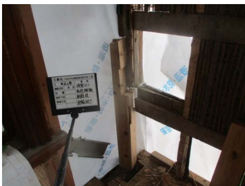
写真 2-4-29 洋室(1)柱部分取替え
