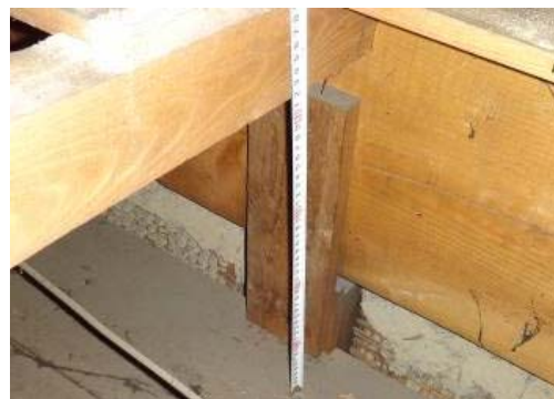
写真 3-1-45 2階床組部分の柱-梁
