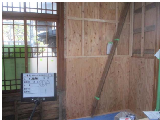
5-8-27 施工中 耐力壁 (④A) 構造用合板 (両面) を新設
