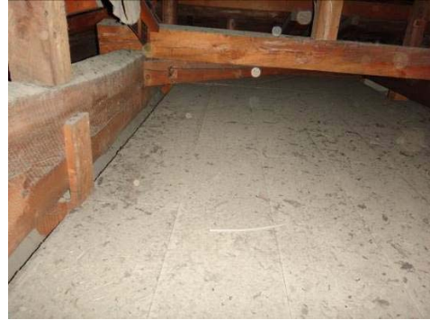
写真3-1-37 2階和室天井裏
