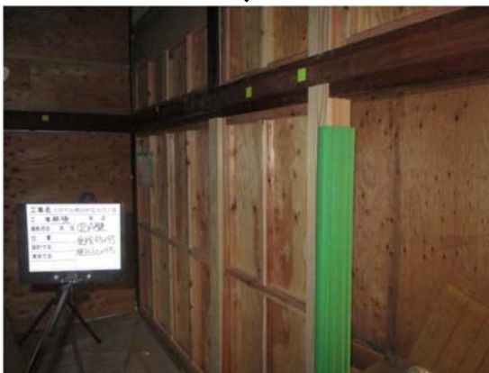
5-8-15 施工中 耐力壁 (②A) 構造用合板を新設
