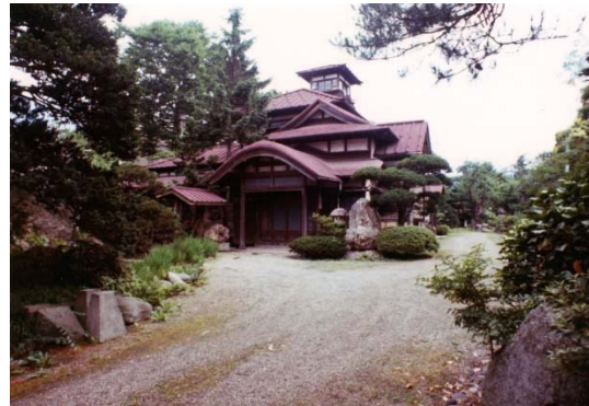
写真 1-1-2 移築前の桜櫓館（南面）
