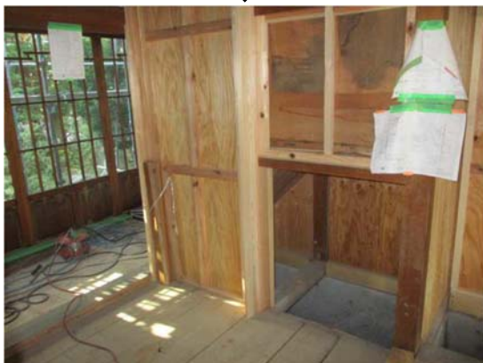
5-8-21 施工中 耐力壁 (③)
