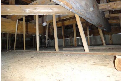
写真3-1-36 1階和室天井の吊り木
