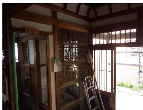
写真 3-1-23 1階玄関壁の木舞
