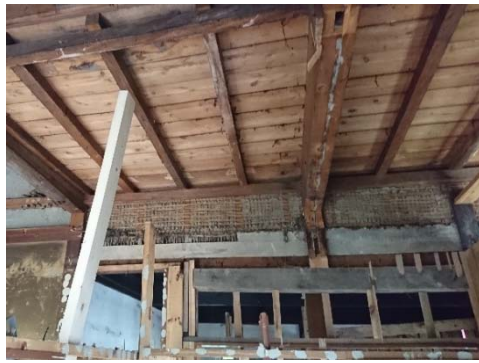
写真 3-2-4 ③梁ホゾ穴の跡
