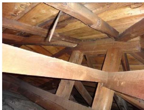
写真 3-1-21 同隅木とそれに掛かる垂木
