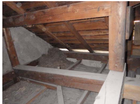
写真3-1-39 洋室(1)天井の下地
