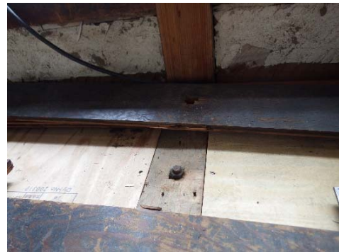
写真 3-1-55 梁上の羽子板のボルト頭
