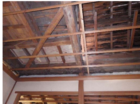
写真 3-1-57 梁に沿って棒鋼取付け
