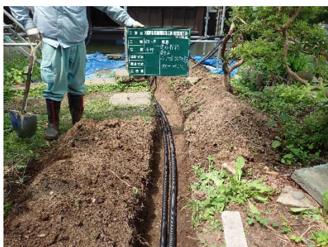
写真 2-4-75 埋設配管
