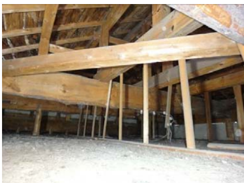
写真 3-1-14 1階和室小屋組
