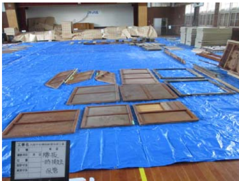
写真 2-4-13 一時撤去材保管状況
