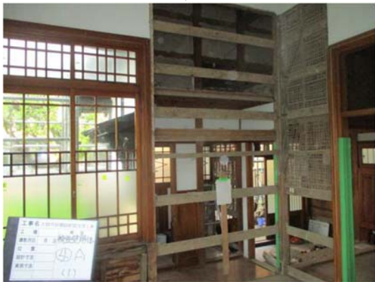
5-8-26 施工中 耐力壁 (④A) 土壁、貫全面撤去
