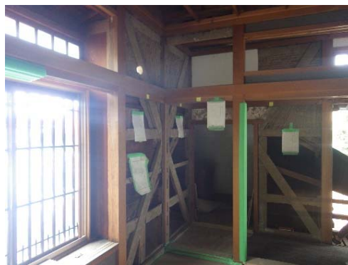
写真 3-1-25 2階縁側(5)の斜材
