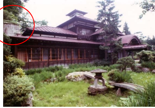
写真 3-2-2 ②南側から見る桜櫓館西側 の物置
