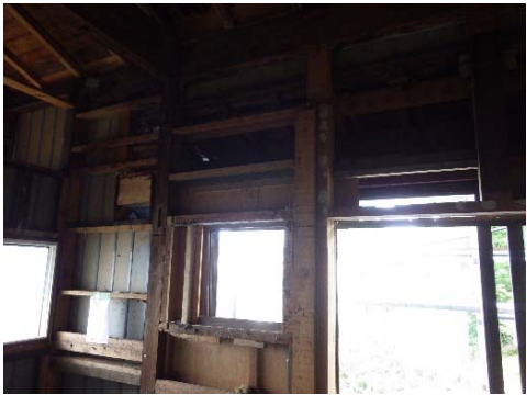
写真 3-1-30 1階台所東側外壁面
