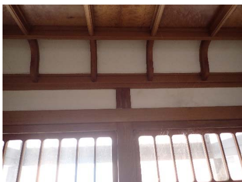
写真 2-4-77 照明配線カバー
