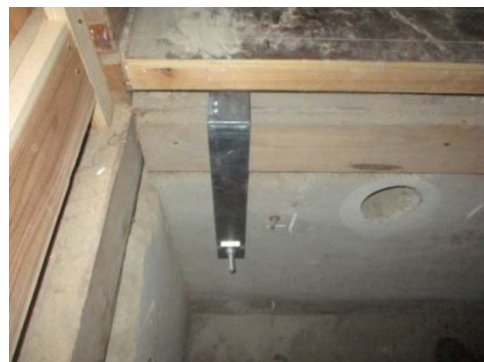
写真 2-4-26 柱脚接合金物 TB1
