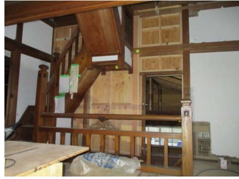
写真 2-4-40 2階構造用合板補強壁
