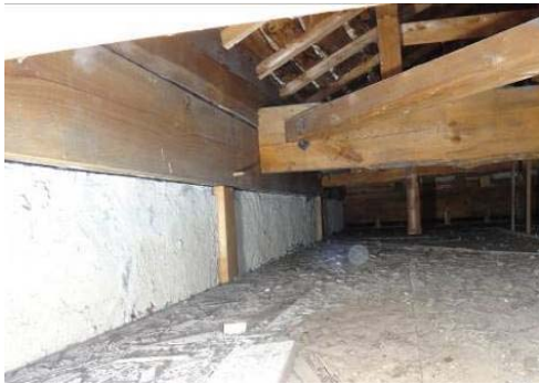
写真 3-1-12 1階和室柱頭と桁
