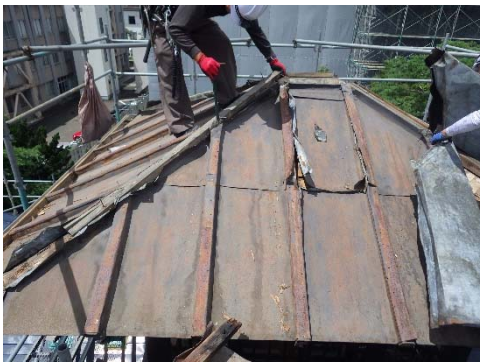
写真 2-4-7 展望台屋根解体
