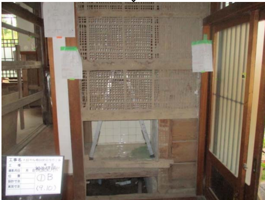
5-8-8 施工中 耐力壁 (①C) 土壁全面撤去
