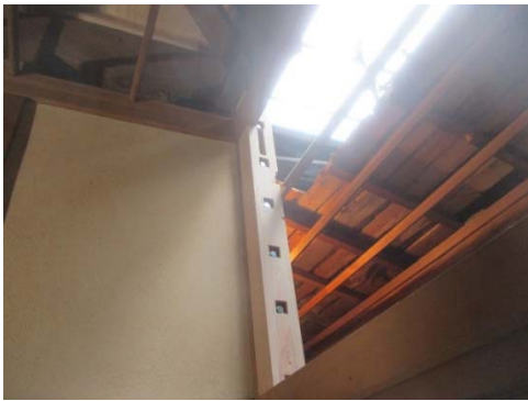
写真 2-4-47 既存梁下端に付柱取付け
