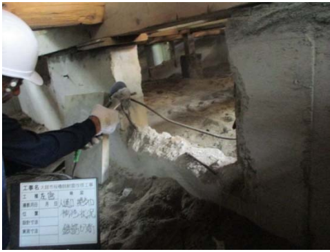
写真 2-4-21 人通口露出鉄筋切断
