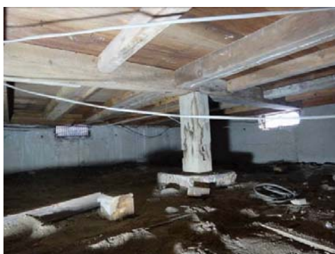
写真 3-1-1 床下の様子 (洋間)
