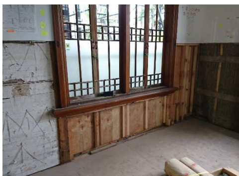
写真 3-1-26 洋室(1)北、東側壁面
