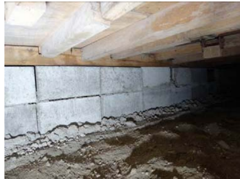
写真 3-1-4 南側縁側部分の基礎
