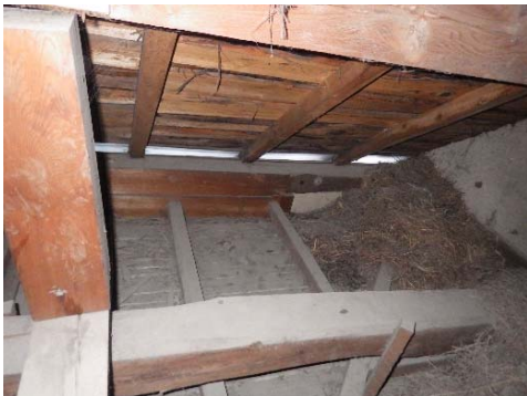
写真3-1-38 洋室(1)天井の吊り木
