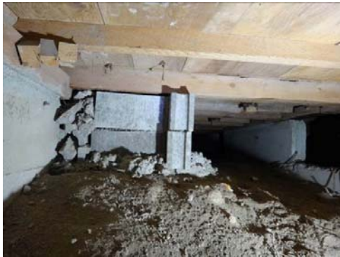
写真 3-1-5 南側縁側部分の基礎（ホール側）
