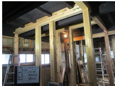
写真 2-4-34 新材取付け
