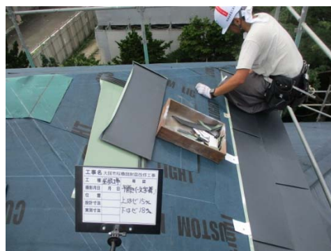
写真 2-4-56 葺き材取付け作業中
