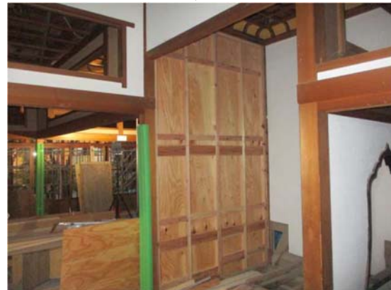
5-8-12 施工中 耐力壁 (②) 構造用合板を新設
