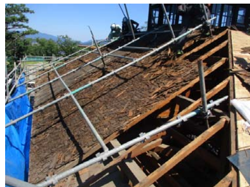
写真 2-4-10 2階屋根解体
