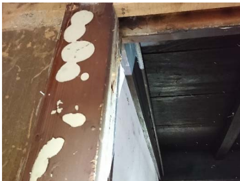
写真 3-1-56 胴差に沿って棒鋼取付け
