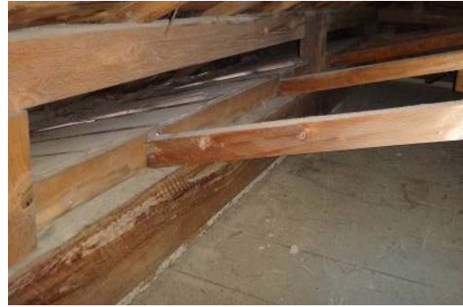
写真 3-1-13 2階和室柱頭の桁と小屋組
