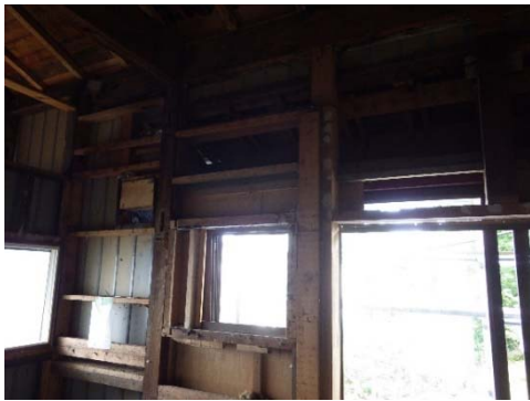
写真 3-2-3 ③柱貫穴の跡
