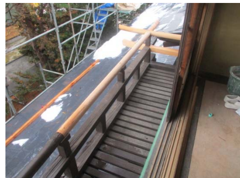
写真 2-4-44 2階手摺部分取替え
