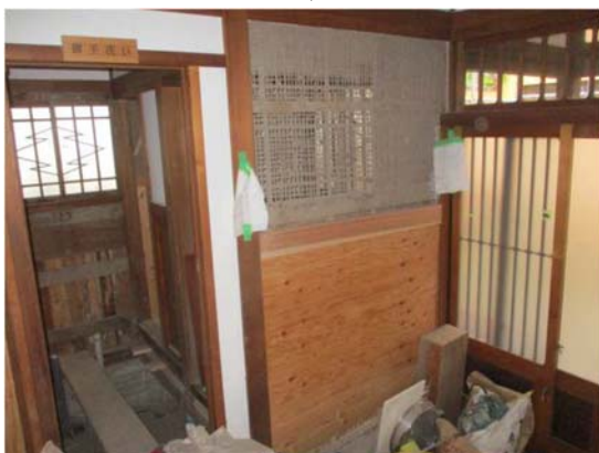
5-8-9 施工中 耐力壁 (①C) 上部土壁復旧、下部構造用合板を新設
