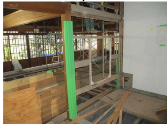
5-8-11 施工中 耐力壁 (②) 土壁、貫全面撤去
