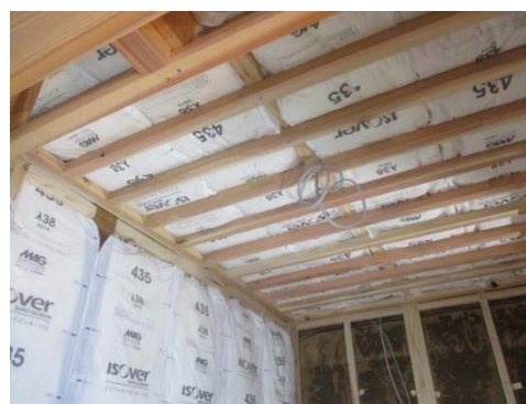
写真 2-4-72 断熱材施工
