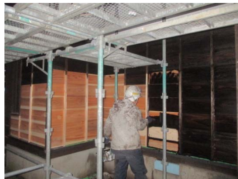
写真 2-4-70 外壁塗装作業中
