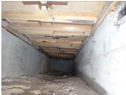
写真 3-1-7 縁側部分の根太と金物
