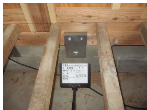
写真 2-4-28 柱脚接合金物 SB1
