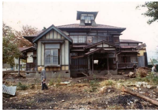
写真 3-2-6 ⑥東側から見た北側 和室の減築
