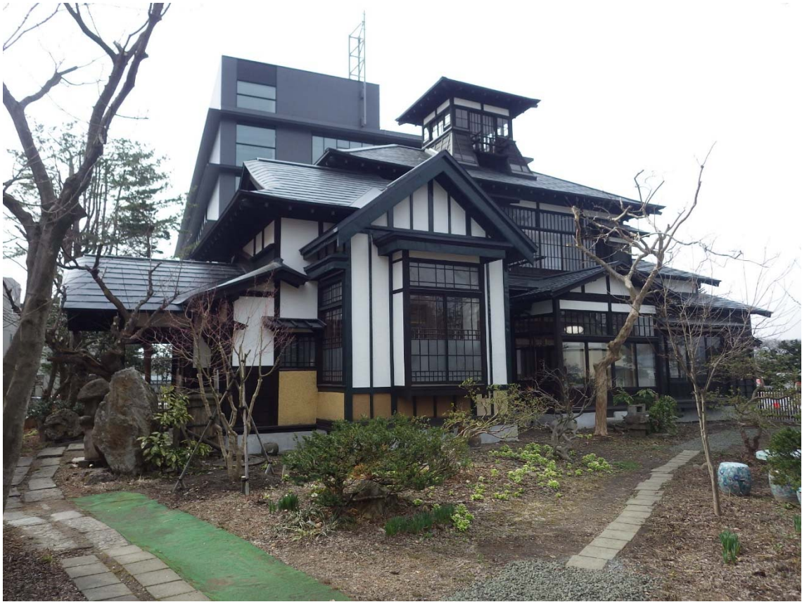
竣工 東・側面全景
