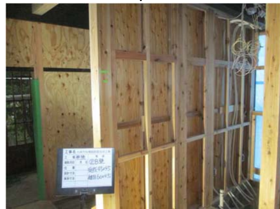
5-8-18 施工中 耐力壁 (②B) 構造用合板を新設
