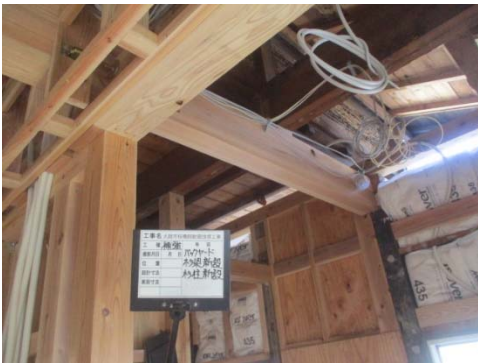
写真 2-4-33 新材取付け
