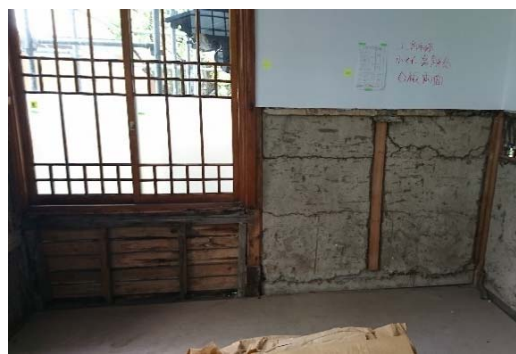
写真 3-1-27 洋室(1)南側壁面
