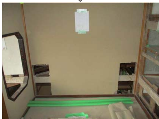
5-8-2 施工中 耐力壁 (①A) 土壁部分撤去
