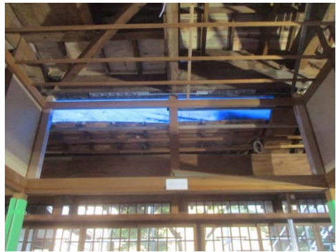
写真 2-4-48 既存梁下端に補強金物取付け
