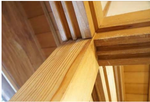
写真 3-1-9 1階和室柱・鴨居・長押
