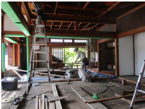
写真 2-4-1 2階天井解体
