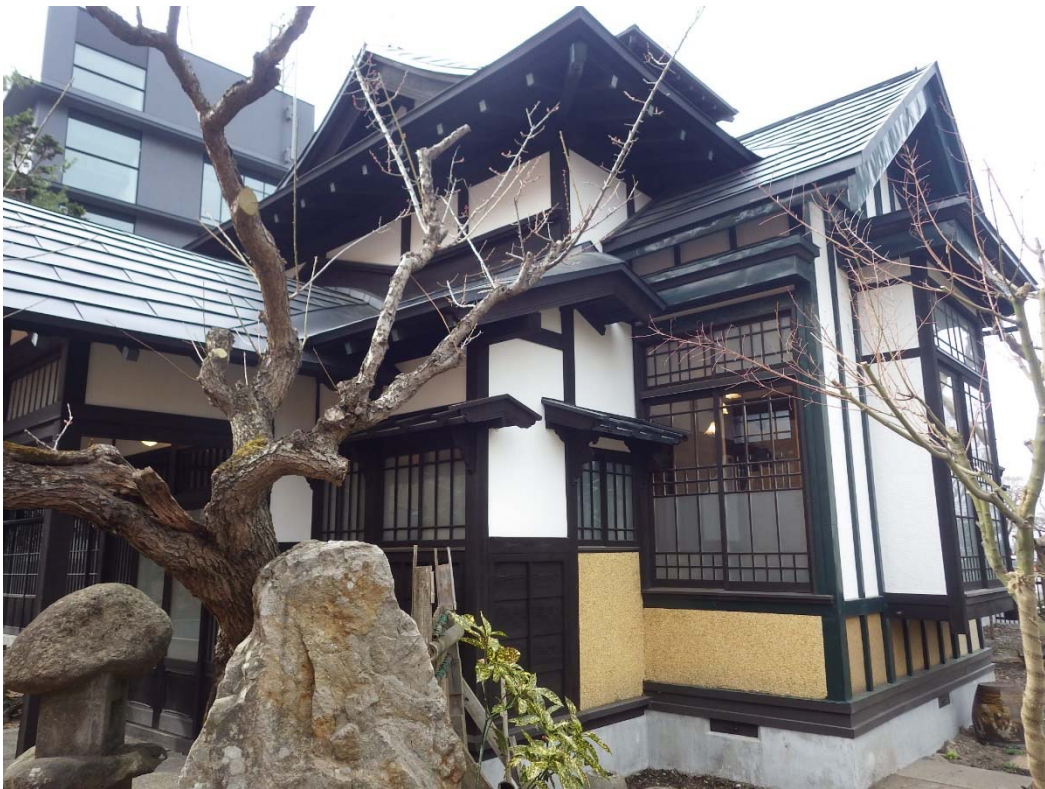
2 南・正面（便所・洋室）
