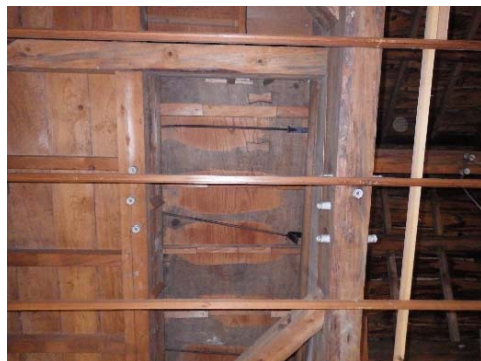
写真 3-1-58 2階床の間下の棒鋼
