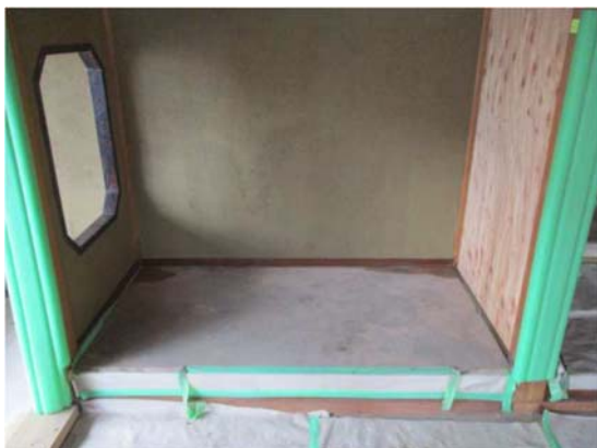
5-8-3 施工中 耐力壁 (①A) 土壁復旧
