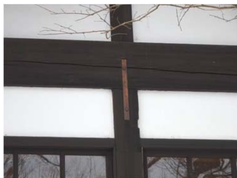
写真 3-1-53 柱-胴差仕口の帯金物補強
