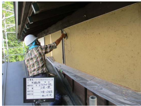
写真 2-4-64 構造用合板下地土壁塗り
