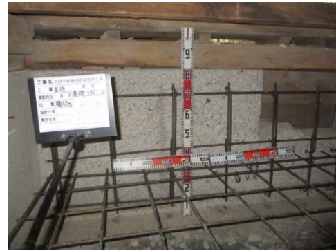
写真 2-4-18 基礎・土間配筋
