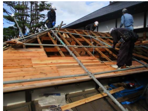
写真 2-4-42 野地板全面取替え
