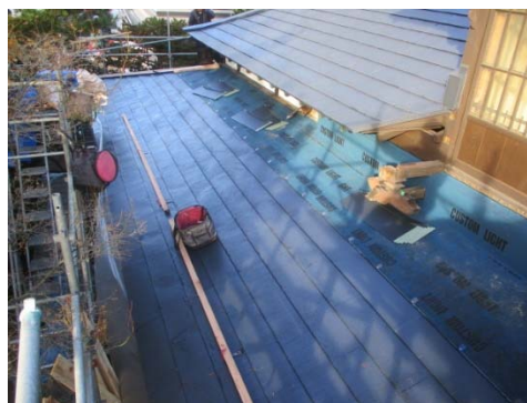
写真 2-4-54 下葺き材立ち上げ
