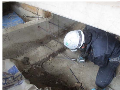
写真 2-4-16 接着系アンカー施工中
