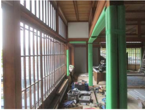
写真 2-4-11 柱・鴨居養生
