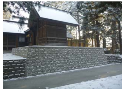
本殿盛土基礎擁壁の再構築(完成後) 化粧型枠を使用した表面仕上げ
