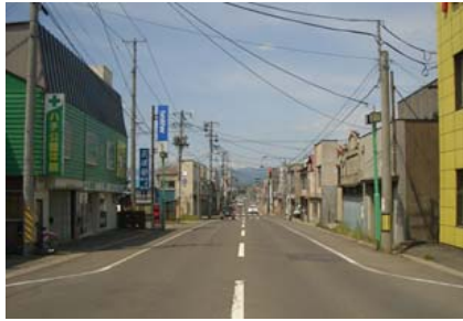
現在の状況写真 (複数の電線の横断状況)
