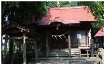
現況写真(正面から撮影)
