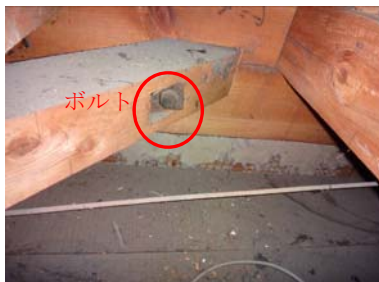
火打ち梁接合部
