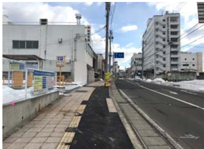
電線共同溝本体工事(着手前)
