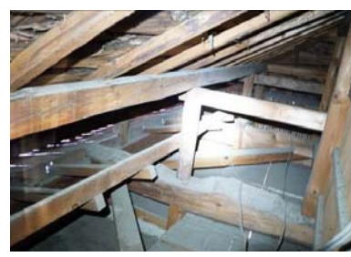
2階座敷梁に渡された火打梁
