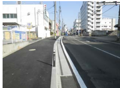
電線共同溝本体工事(完了後) ※歩道部舗装の美装化は最終年度に施工予定
