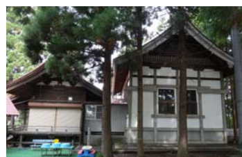
現況写真(南側から撮影)
