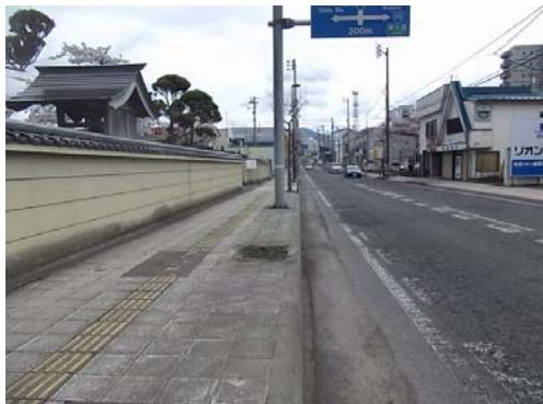
電線共同溝本体工事(着手前)
