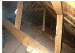
覆屋根(小屋裏状況)
