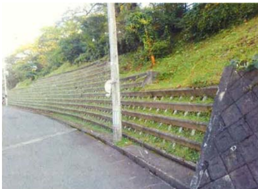
北側斜面の刈り払い(完了後)
