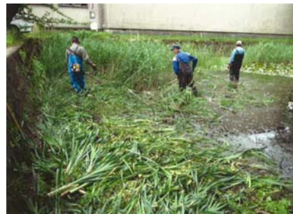
堀に繁茂している草の刈り払い 除去作業状況
