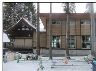
大館八幡神社覆屋建替(R1.2完成)
