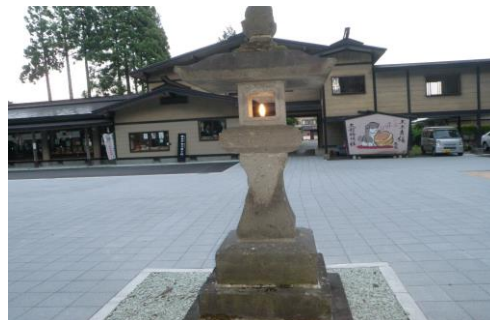
灯籠に照明設置(拝殿前)
