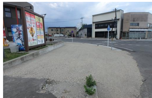
電線共同溝本体工事(完了後) ※歩道部舗装の美化化及び抜柱は 次年度以降に施工予定
