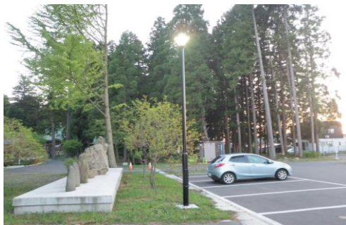
照明灯の設置(駐車場)
