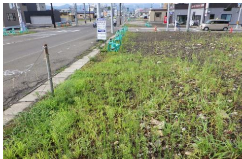
電線共同溝本体工事(着手前)
