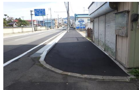
電線共同溝本体工事【上り線】 (完了後) ※歩道部舗装の美装化及び抜柱は 次年度以降に施工予定
