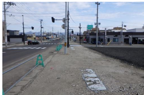
電線共同溝本体工事(完了後) ※歩道部舗装の美装化及び抜柱は令和4年度以降に施工予定
