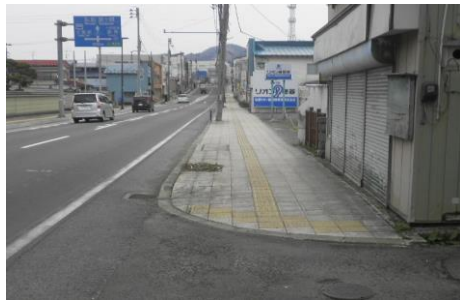
電線共同溝本体工事【上り線】 (着手前)
