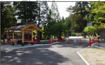
大館神明社(手水舎改修・曳山車通路完成)
