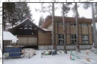
八幡神社(覆屋建替工事完成)
