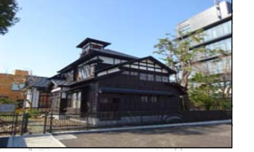
桜櫓館(耐震改修工事完成) 令和3年4月から公開・貸館を再開
