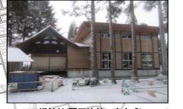
八幡神社(覆屋建替工事完成)
