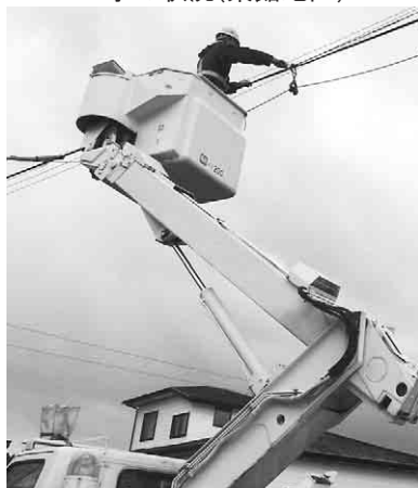
工事の状況(東館地区)
