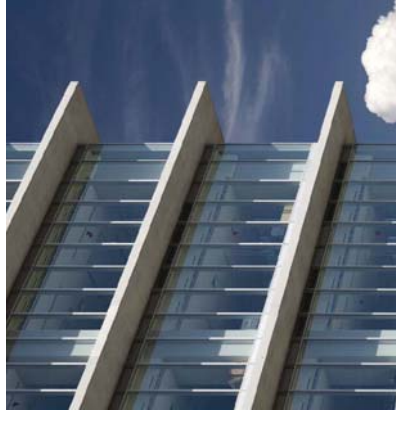
庇による陰影、ガラスとの組み合わせ
