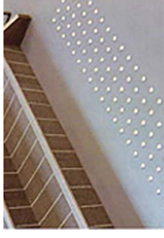
階段_昇降部点字ブロックの敷設
