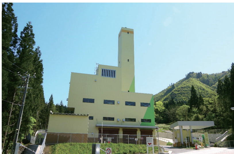
写真 大館クリーンセンター
