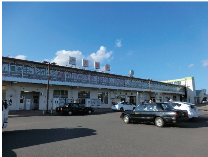
写真 大館駅前
