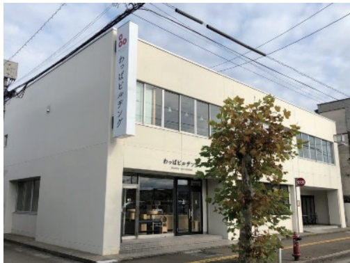
民間によるリノベーション事例 「わっぱビルディング」
