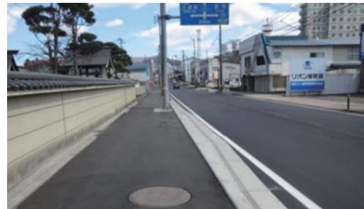
電線共同溝整備事業事例 「一般国道7号長倉地区」
