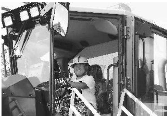
ぼくに任せて！ (舗装工事見学 H.28. 8.4)
