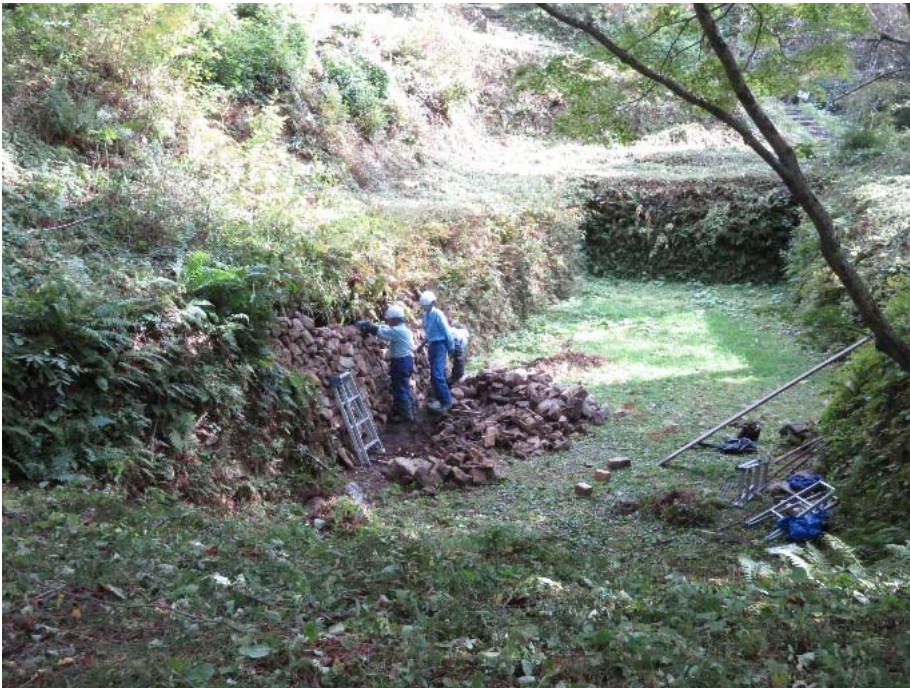
4号倉庫石積壁の修繕工事(2015. 10. 7)
