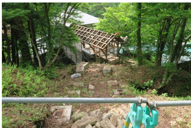
屋外渡り廊下等工事の様子
