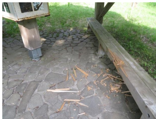
2号指定地東屋のベンチ (クマによる被害と推定される)
