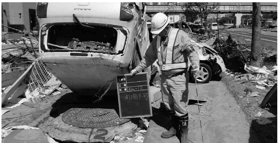
下水道の管路を調査する職員 (4月6日、宮城県多賀城市)
