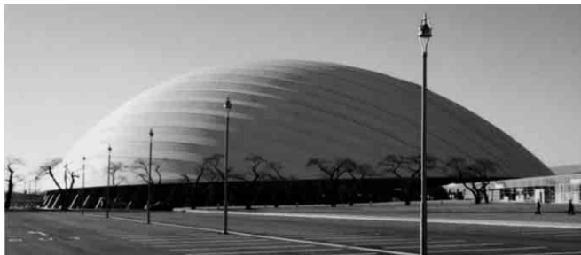
樹海ドーム完成
