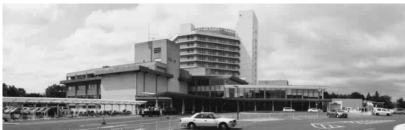
現在の総合病院正面玄関口
