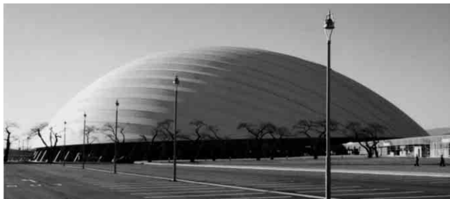
樹海ドーム完成
