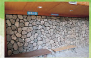
風穴から引き込んだ冷風が吹き出す壁(風穴館1階)
